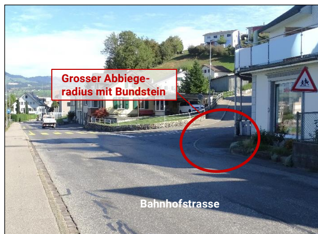
Abb. 25: Knoten Blatten-/Bahnhofstrasse aus der Bahnhofstrasse, Foto: R+K
